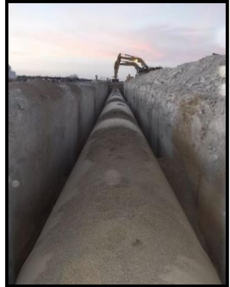
Instalación de tubería de 108 pulgadas en la sección 17 de IPL
